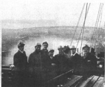
Des investisseurs américains à bord de la Place Ville-Marie, au moment de la construction de son toit.
